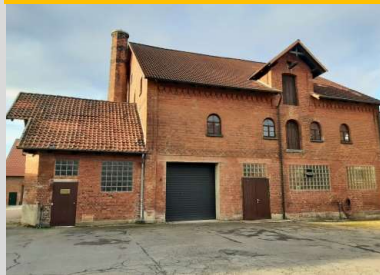
Heizzentrale mit Spitzenlastheizung
