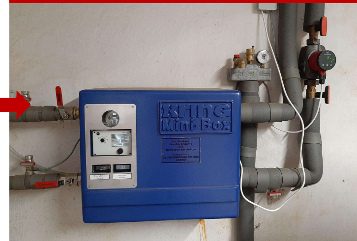
Übergabestation (Wasser-Wasser-Wärmetauscher) in jedem anzuschließenden Haushalt
