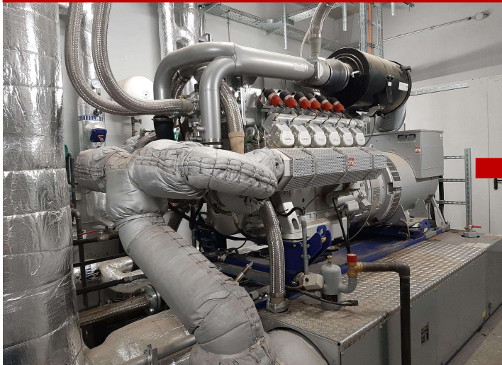
Biogasverbrennung im BHKW
